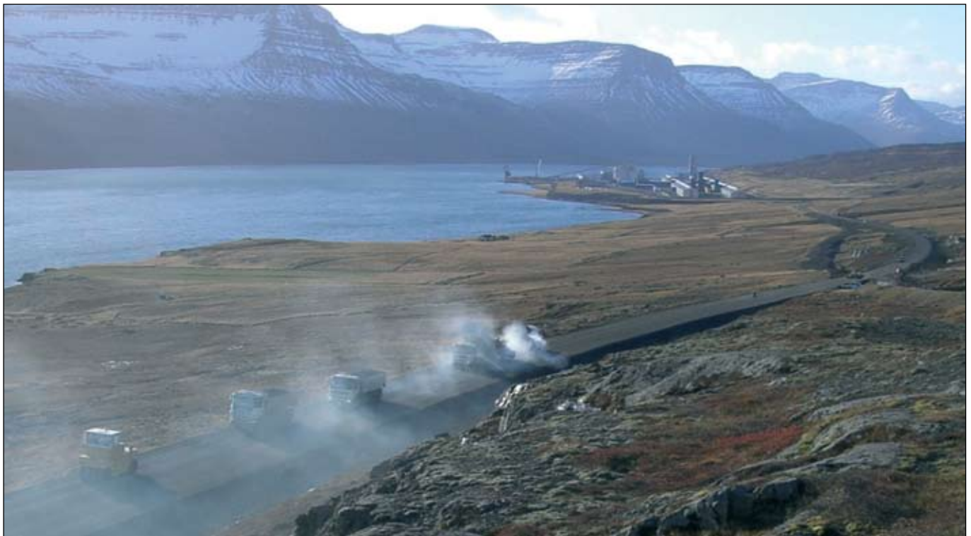
Malarvinnslan á Egilsstöðum að klæða Norðfjarðarveg á Hólmahálsi 15. október fyrir verktakann Suðurverk. Mynd: Einar Þorvarðarson.
