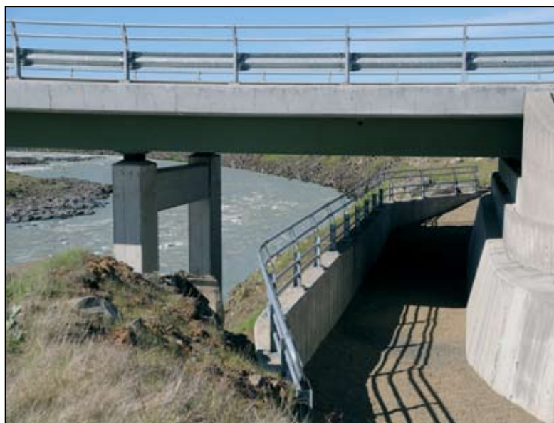
Reiðleið undir brú yfir Þjórsá
