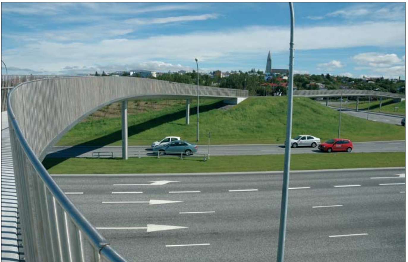
Göngubrýr yfir Njarðargötu og Hringbraut.
